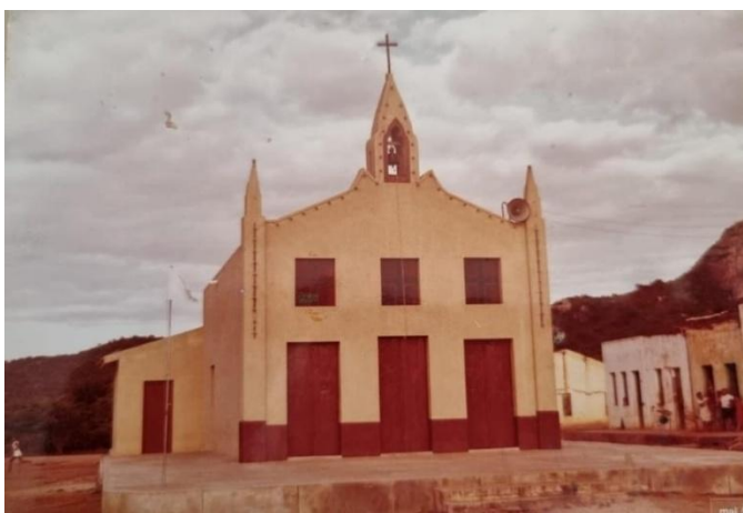
Figura 2.1 – Fachada da Capela/Igreja de São José, em 1984
